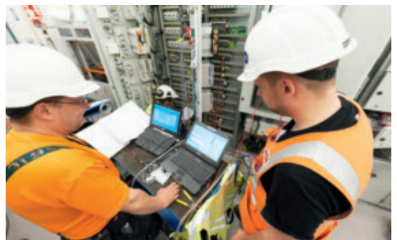
Pienjännitekojeistojen uusinta on osa OLI:n ja OL2:n pitkän aikavälin kehittämistä.
