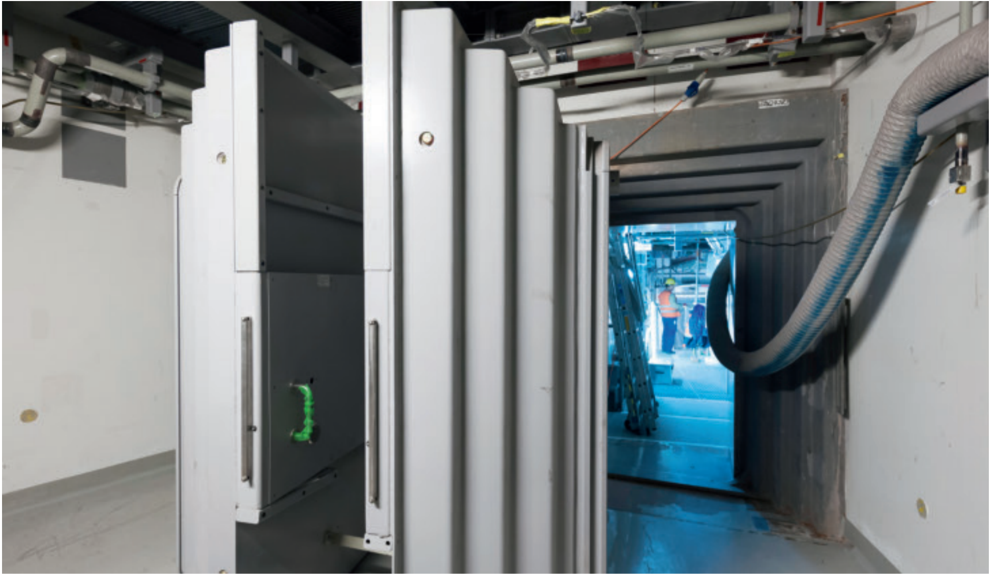
Höyrytintilaan johtava ovi on massiivisen kokoinen. Sen tehtävänä on estää höyrytintilasta tuleva säteily.
