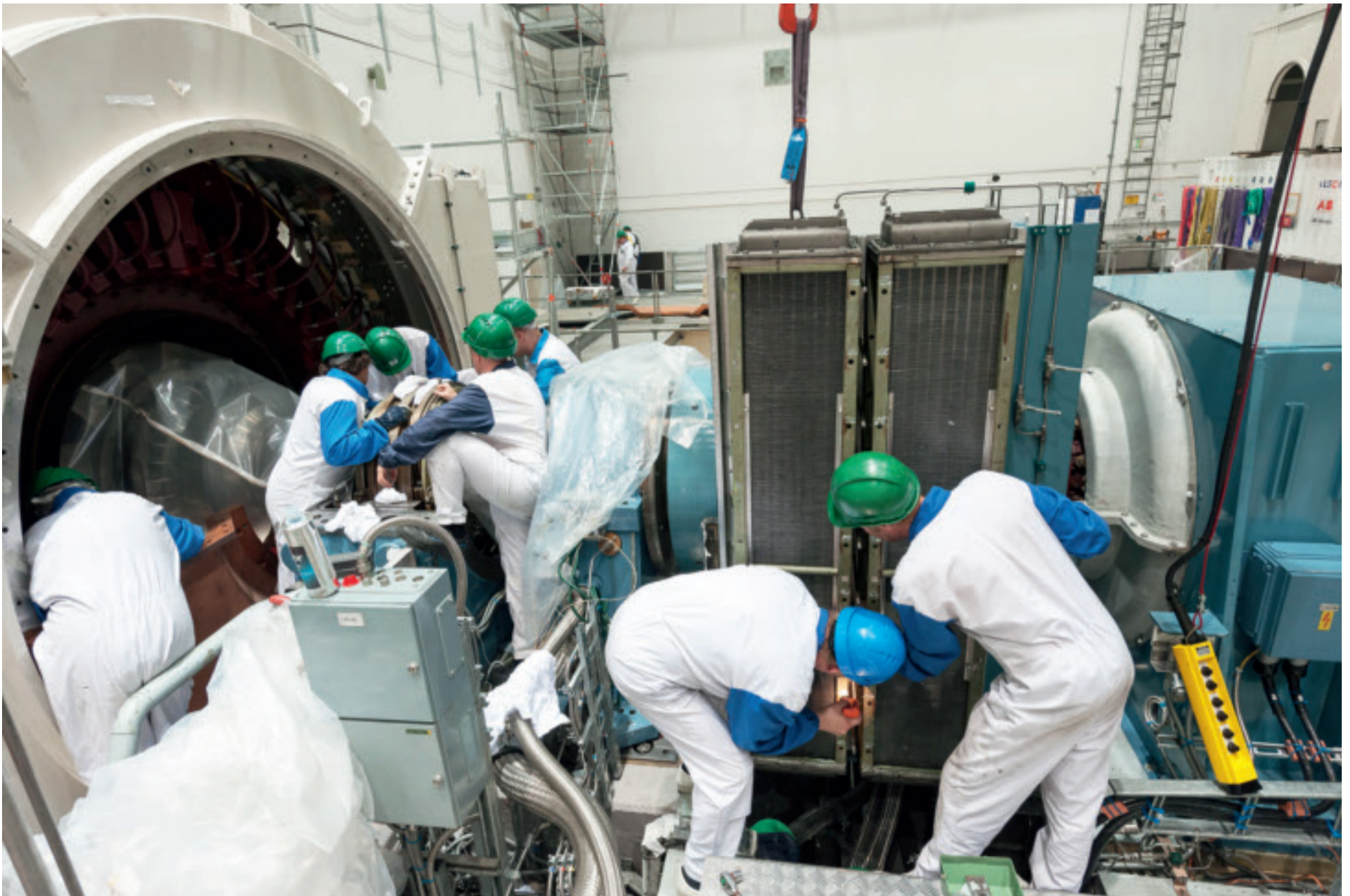
Generaattorin staattorin korjaus oli yksi OL2:n huoltoseisokin merkittävistä töistä.
